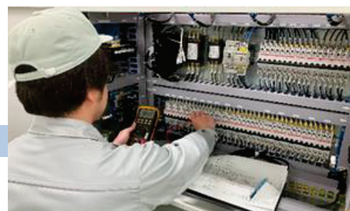
配線・通電検査
